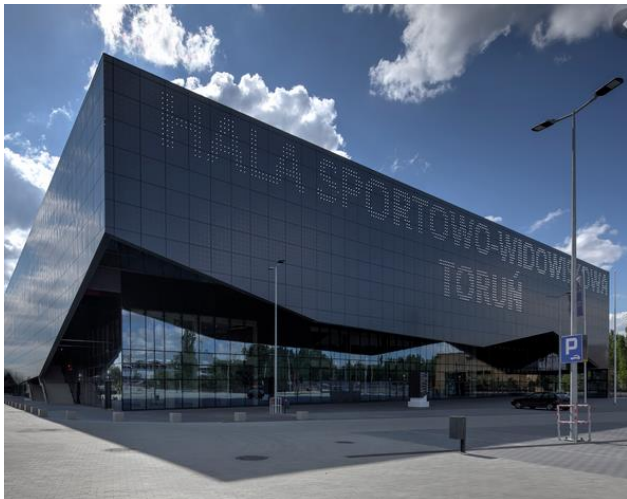
HALA SPORTOWO –WIDOWISKOWA
